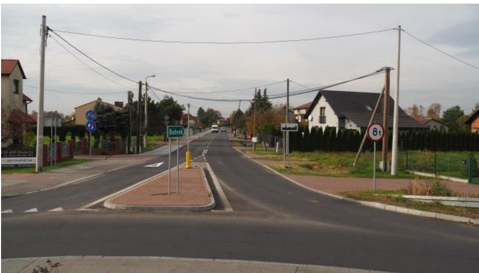
Przebudowana ul. Nadwiślańska w Bobrku.
