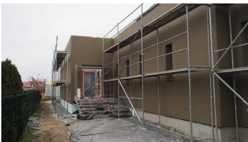
Trwająca budowa przedszkola w Samorządowym Zespole Szkół w Gorzowie. Zakończenie prac nastąpi w 2023 r.
