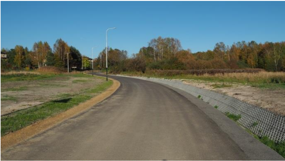
Wybudowana ul. Brzechwy w Chełmku.
