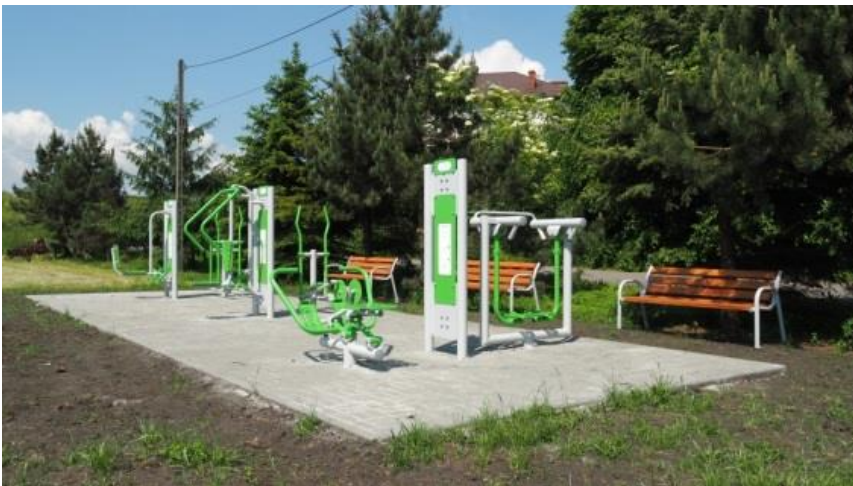
Wybudowana siłownia na świeżym powietrzu w strefie sportowo-rekreacyjnej przy ul. Rzeczej w Gorzowie.
