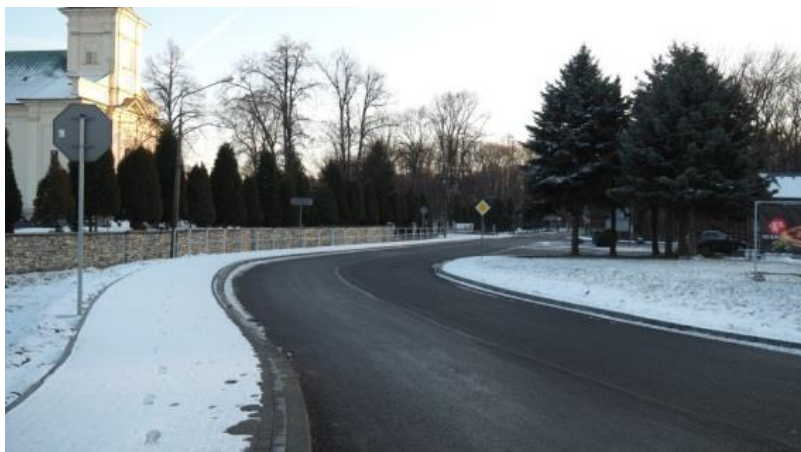
Przebudowana ul. Nadwiślańska w Bobrku.
