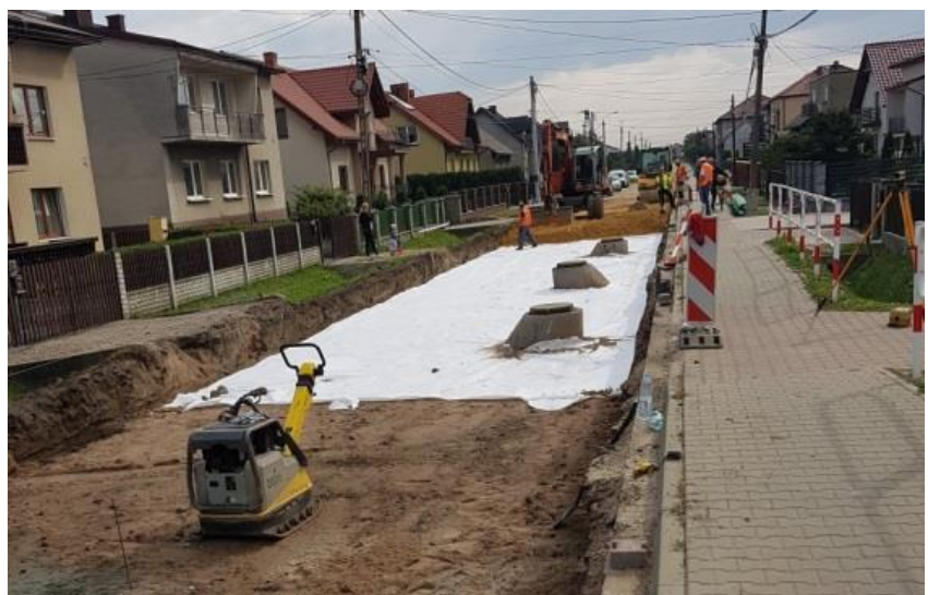
Budowa kanalizacji w ul. Nadwiślańskiej w Bobrku.
