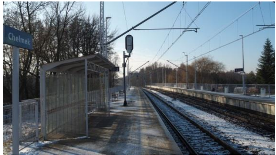
Zmodernizowana linia kolejowa nr 93 w Chelmku.
