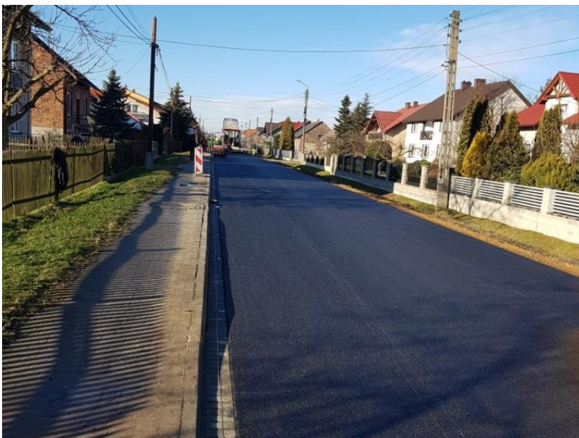
Wybudowana kanalizacja sanitarna w ul. Nadwiślańskiej w Bobrku.
