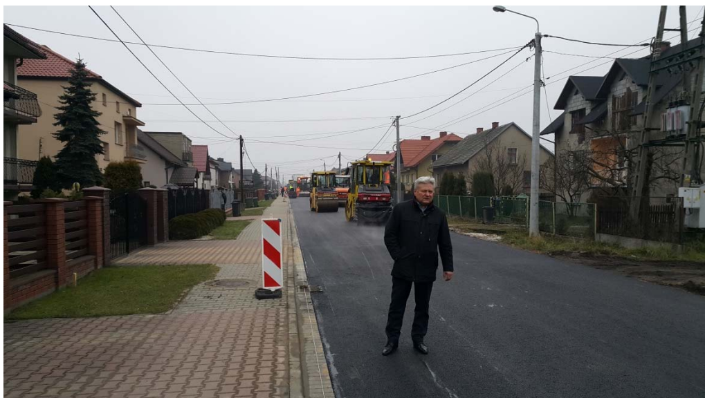
Budowa kanalizacji sanitarnej w ulicy Nadwiślańskiej w Bobrku
