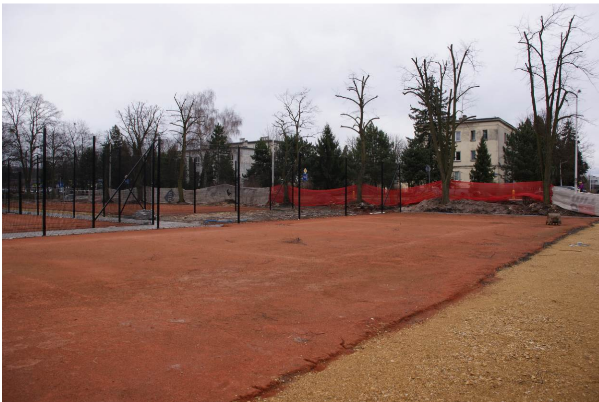
Korty tenisowe w trakcie realizacji
