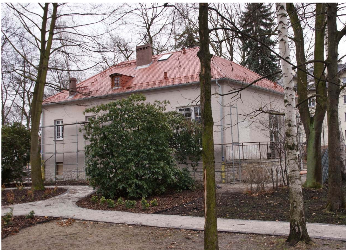
Dom Seniora w trakcie realizacji
